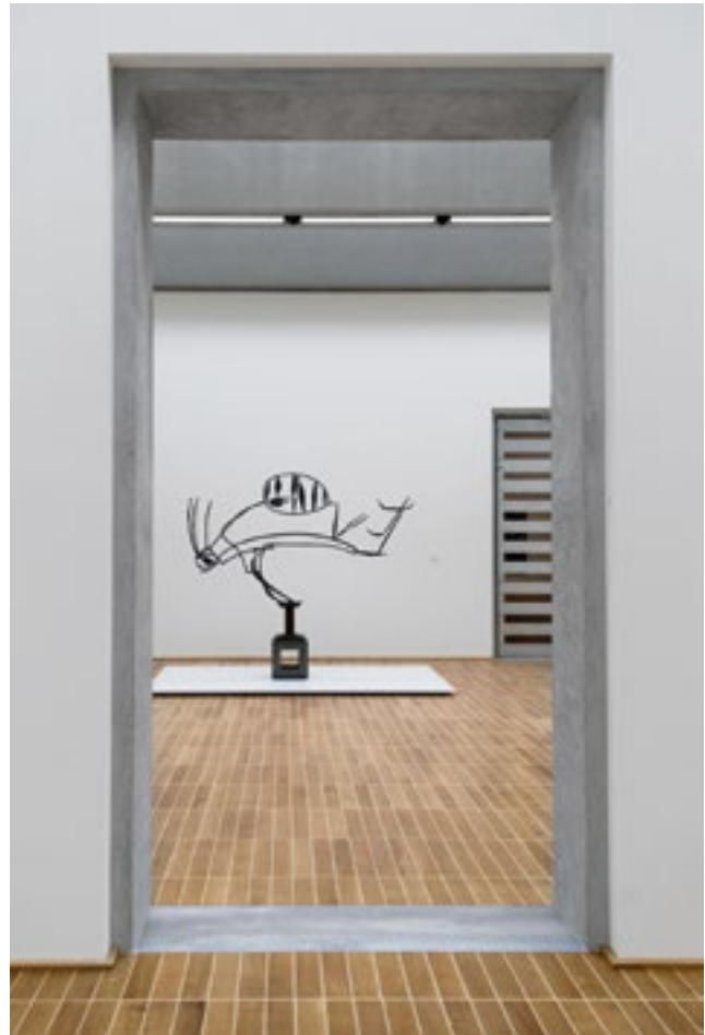
In den Ausstellungsräumen stehen 10 cm starke Gipswände vor der tragenden Betonwand, jeweils sichtbar in den Laibungen.
