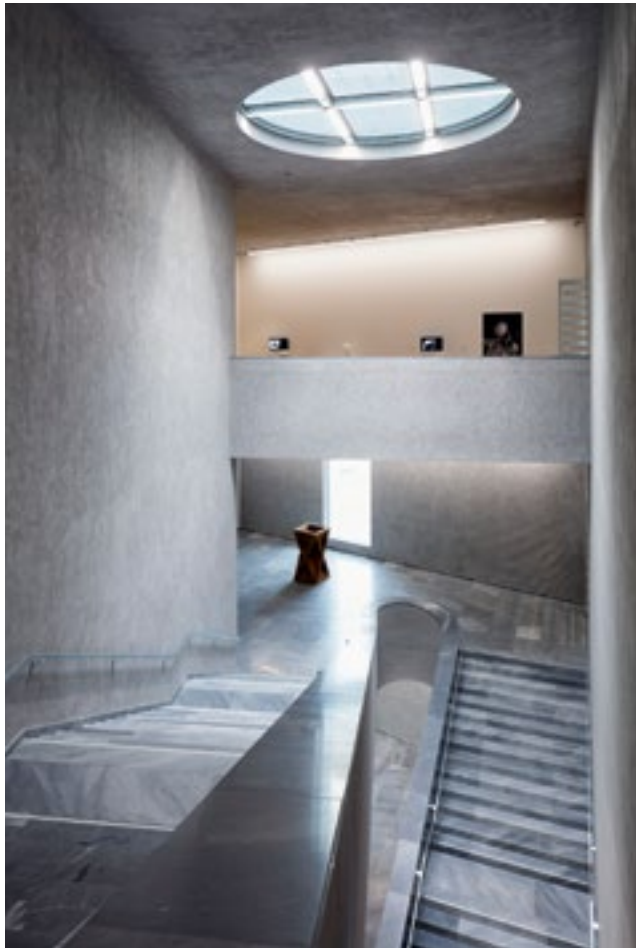
Das Treppenhaus mit den schräg gegeneinander versetzten Treppenläufen erhält über eine rundes Oberlicht Tageslicht.
